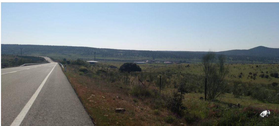
Vista hacia el sur de los terrenos SNUP-N5 desde la EX.108. Puede apreciarse la elevada visibilidad de esta parte desde el entorno lejano, por su posición elevada.
